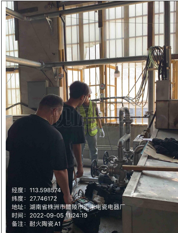
烧结废气排气筒进口
