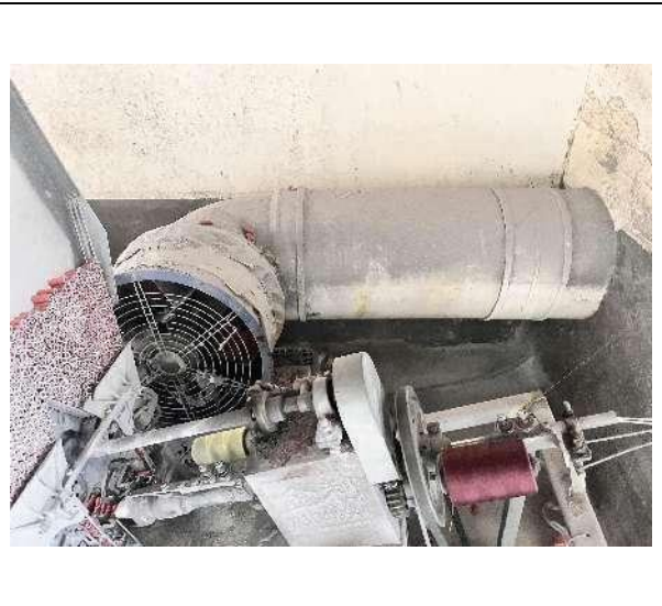
主产区结鞭车间采取集气装置+排气管道+水浴除尘系统
