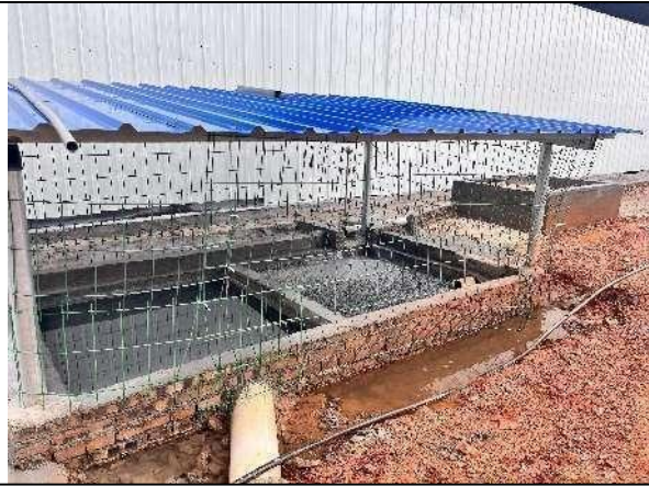
金沙塘工区一级沉淀池
