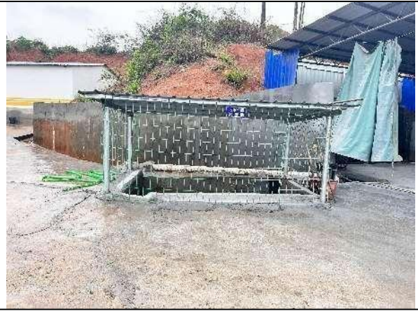
金沙塘工区一级沉淀池
